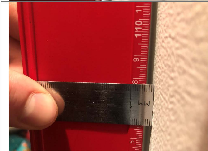
Фото №8. Измерение уровня стен кладовки в квартире.
