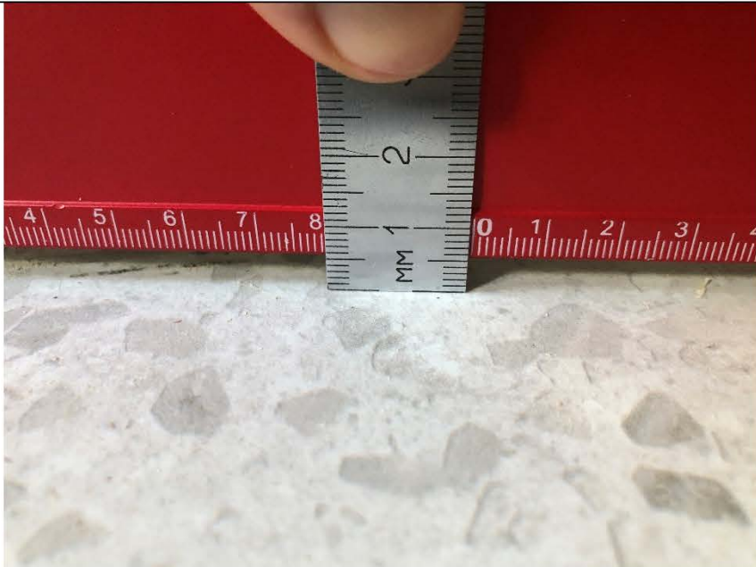
Фото №43. Измерение напольного покрытия в кухне в квартире.
