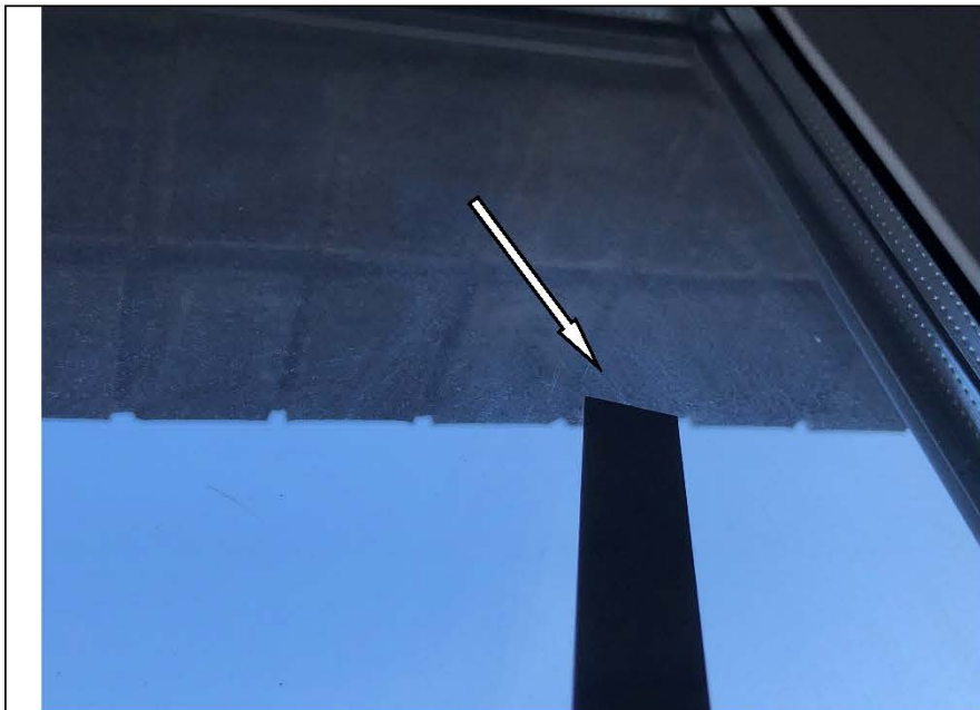
Фото №34. Царапина на стеклопакете оконного блока ПВХ в кухне в квартире.
